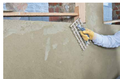
6. Opracování povrchu mřížkovým škrábákem
