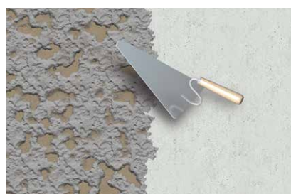
1. Nanesení jádrové omítky (v případě potřeby)
