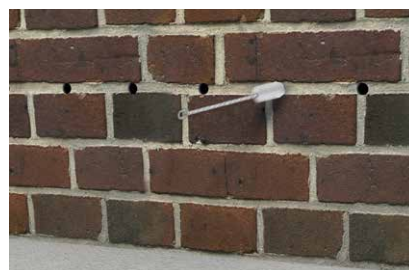
3. Vyčištění otvorů
