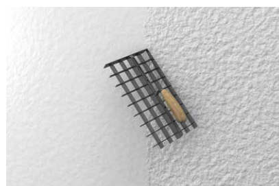
otevření povrchu mřížkovým škrábákem
