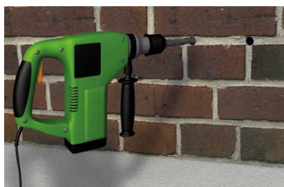
2. Vrtání injektážních otvorů
