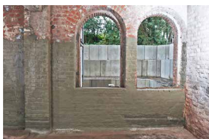
2. Hydroizolace (v případě potřeby)
