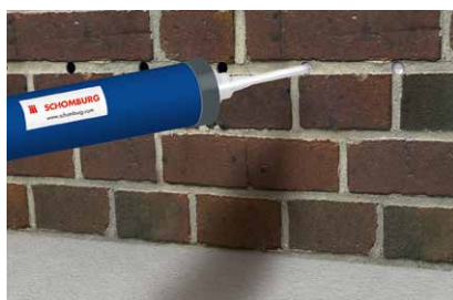
5. Vytvoření horizontální clony (pomocí injektážního krému)
