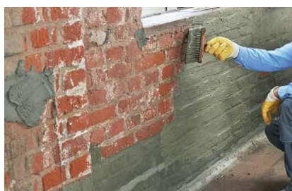
1. Příprava napojení stěna/podlaha
